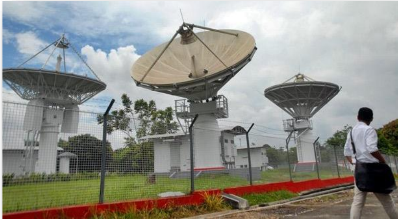
Transmitted dari Telkom Cibinong
