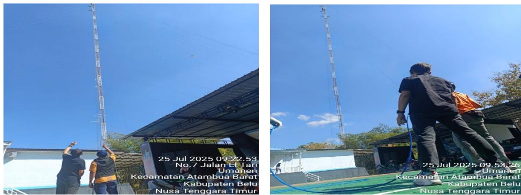
Gambar .... Pemantauan Pemindahan Tower Triangle
