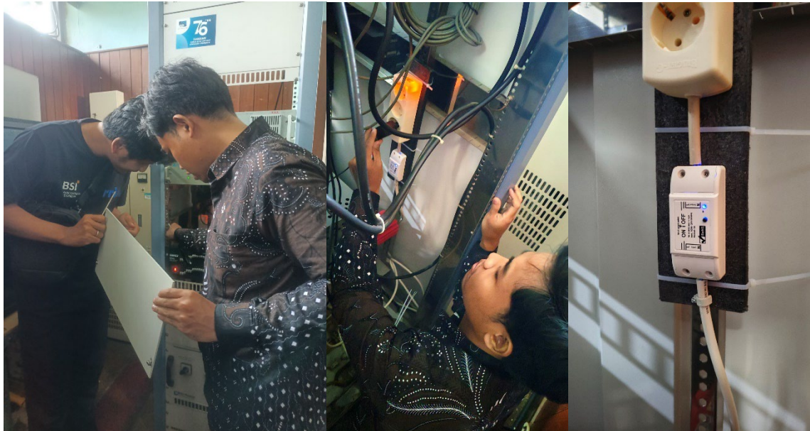
Pemasangan smart switch pada DVB receiver
